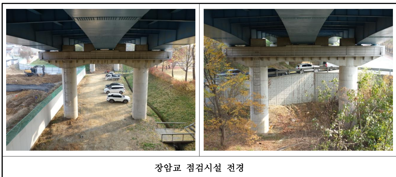
【그림 6.3】 점검시설 설치 현황
